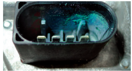
Korozyon izleri olan montaj soketi
