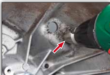
Bild 5: Uppborring av öppningarna
