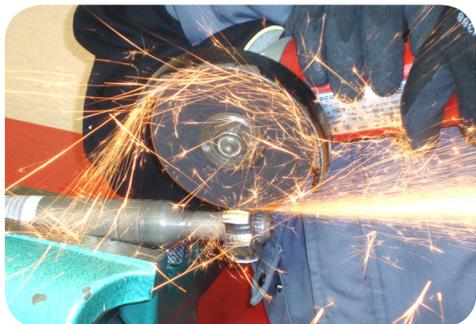
4. Corte os trilhos do canal interno, em 2 ou 3 pontos, utilizando uma ferramenta de corte adequada.
